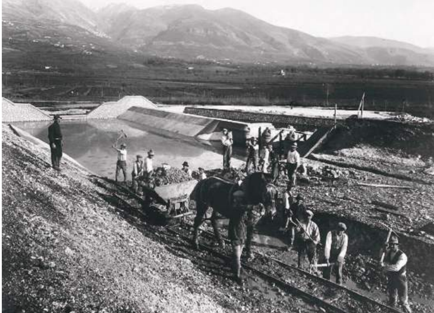
Lavori per la realizzazione del Canale di Santa Susanna, Rivodutri, 1935 Foto Archivio Consorzio della Bonifica Reatina
