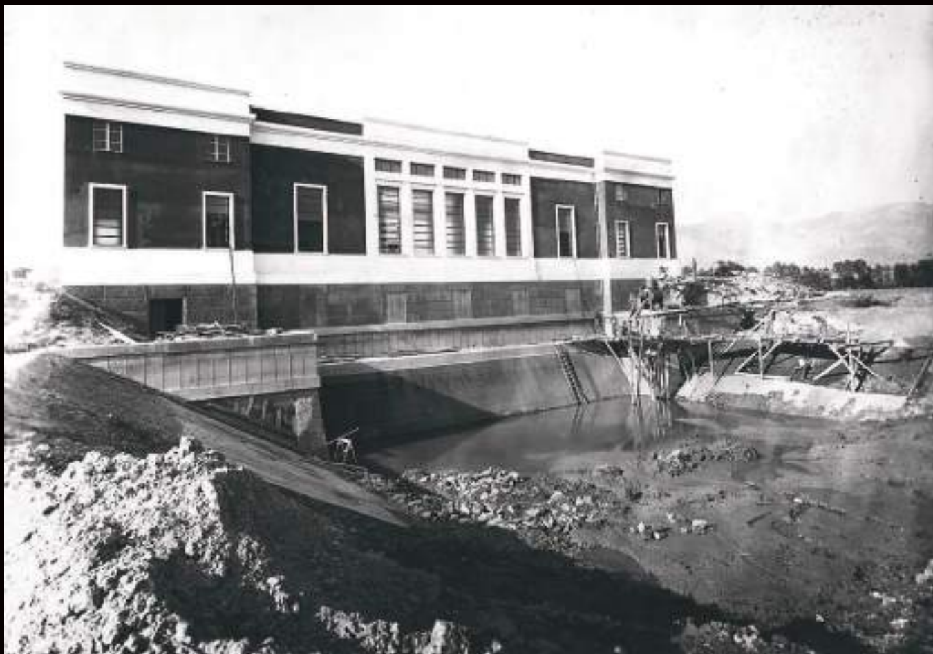
Impianto Idrovaro di Ripasottile durante i lavori di realizzazione
