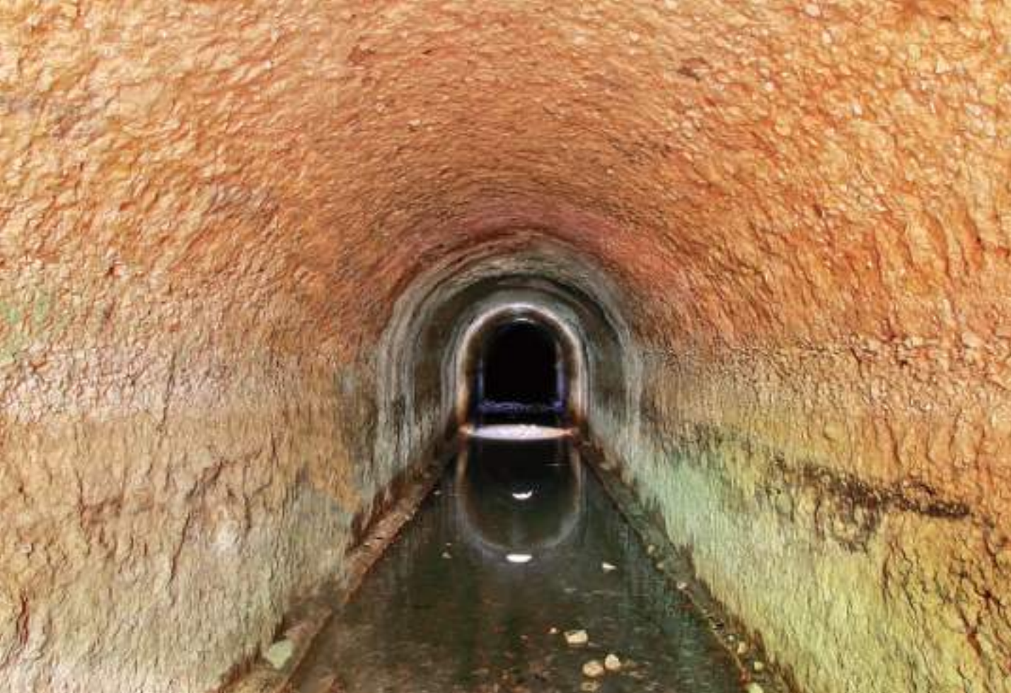
Cisterna del Castellano, Monteleone Sabino
